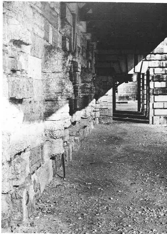
9 Blick entlang eines der Gebäude zur Salzfabrikation
